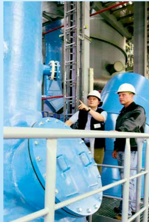
Sichtprüfung am Teilstück des 12 Meter hohen Wäschers.
