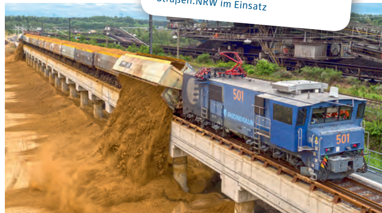
↑ GRUNDLAGE: Auf der Entladebrücke wird fruchtbarer Boden ausgekippt.
