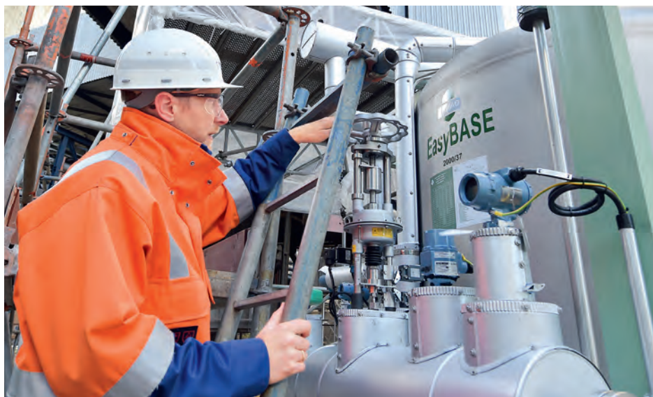
➔ EU-Projekt: Die Testanlage für „Methanol from CO 2 “ wird im Innovationszentrum Kohle im Kraftwerk Niederaußem gebaut.
