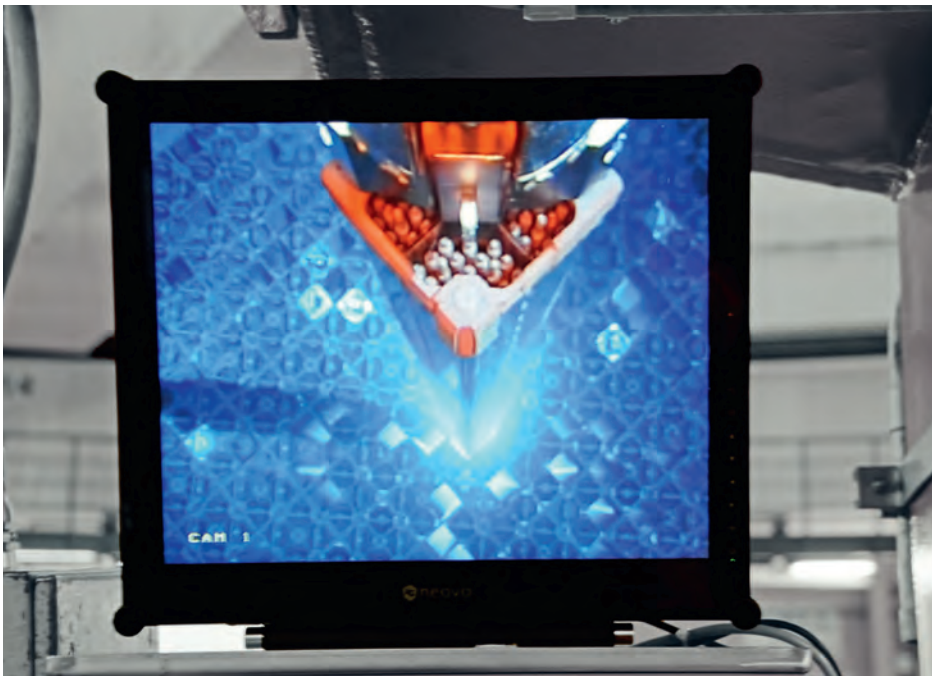
↑ BLICK hinter die Kulissen: Spezielle Kamertechnik ermöglicht es, den Brennelement-Wechsel live unter Wasser zu beobachten.
