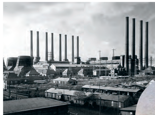
Wie alles begann: Hugo Stinnes erkannte früh das Potenzial des ersten Elektrizitätswerks in Essen.
