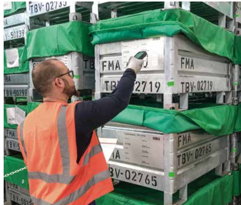
Im stillgelegten Kraftwerk Biblis hilft ein digitales Logistik-Tool beim reibungslosen Rückbau.
