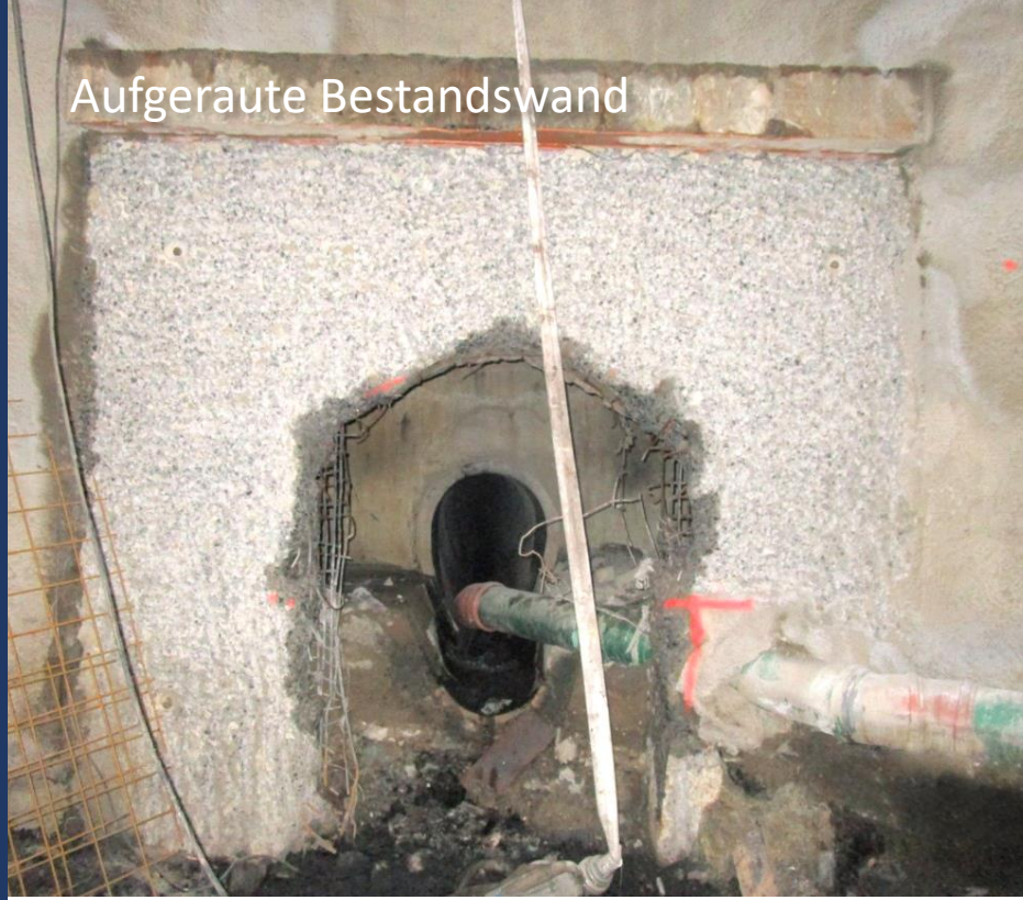
Gebohrte Anschlussbewehrung
