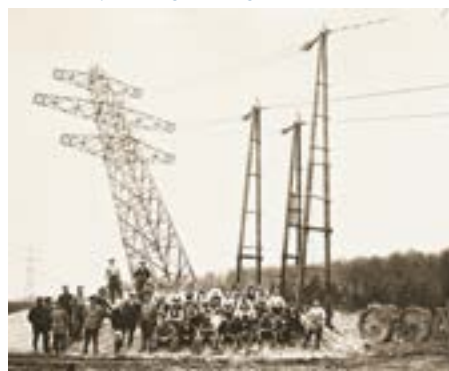
↓ 1930: RWE errichtet die erste überregionale Hochspannungsleitung in Deutschland.
