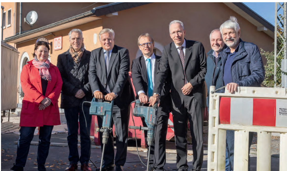
→ ES GEHT LOS: Der Grundstein für das „InfoCenter indeland“ ist gelegt.
