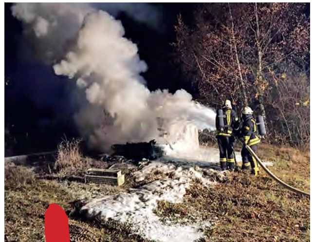
↑ LÖSCHARBEITEN des brennenden Trafohauses.
