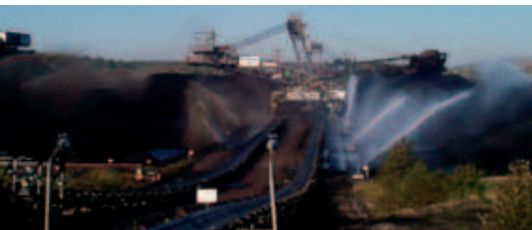
Staubbekämpfung im Kohlebunker
