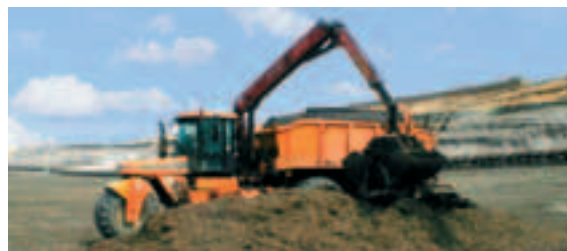
Auftrag von Kompost auf länger freiliegenden Tagebauflächen
