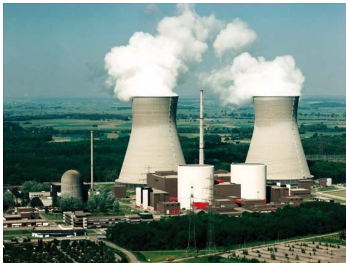
Leistungserhöhung und bessere Ausnutzung des Brennstoffes sorgen für Effizienzverbesserungen in Kernkraftwerken wie in Gundremmingen
