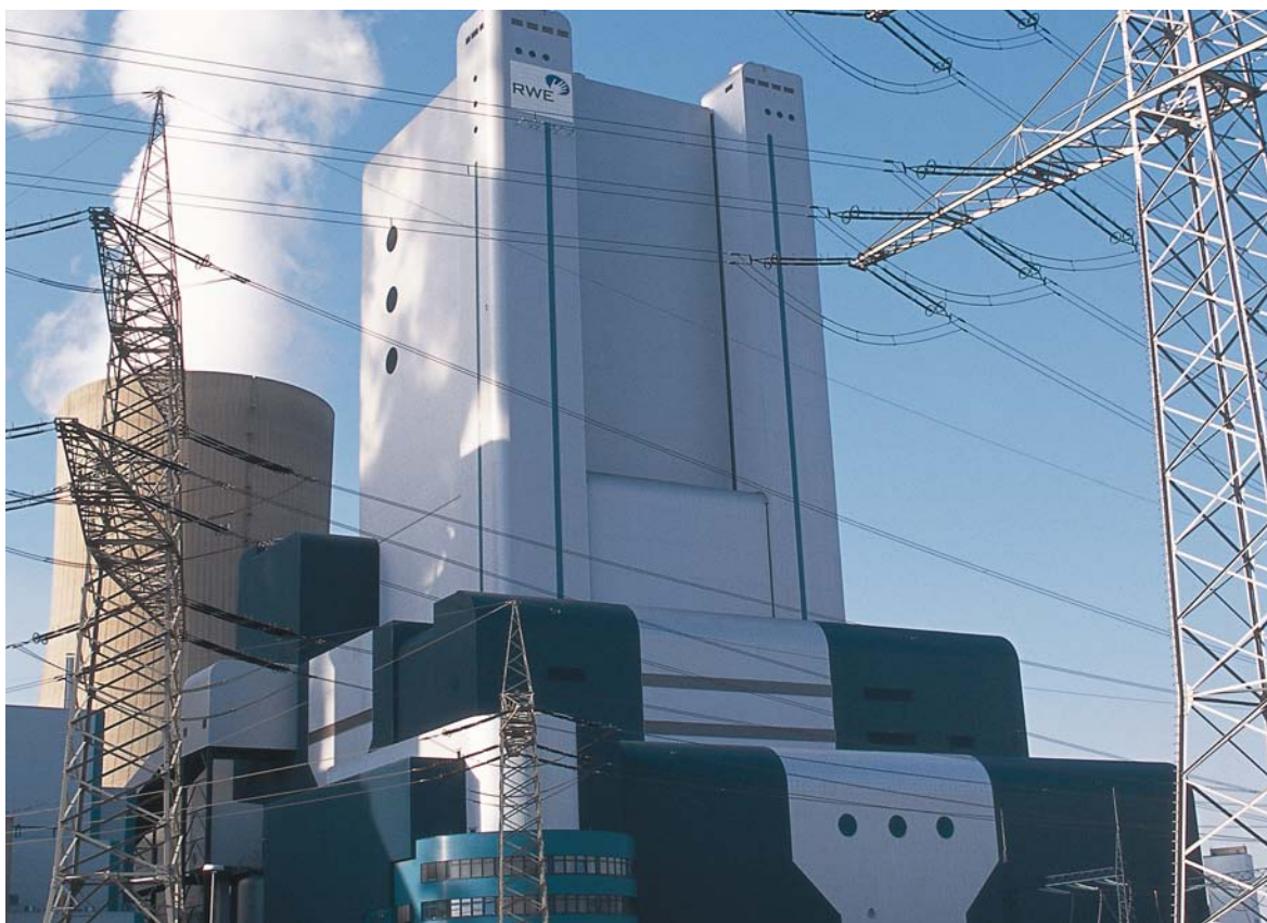
Das Braunkohlekraftwerk mit optimierter Anlagentechnik (BoA) Niederaußem – ein Meilenstein effizienter Kraftwerkstechnik
