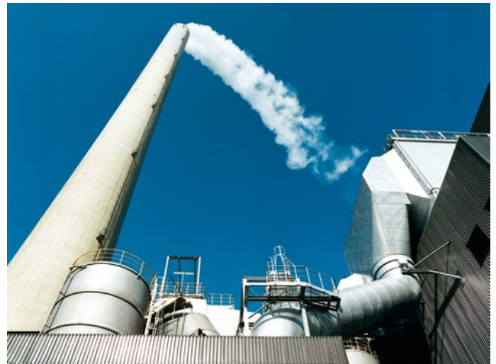
Durch Einbau einer neuen Rauchgasentschwefelungsanlage im Kraftwerk Voerde wurde die Leistung pro Block um je 50 MW erhöht
