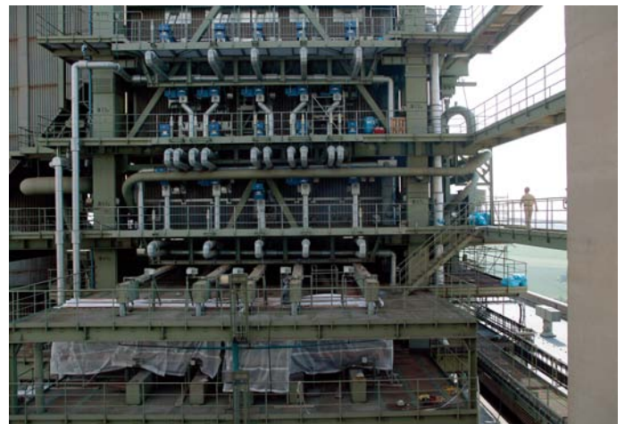
Durch Braunkohlevortrocknung kann der Wirkungsgrad zukünftiger Kraftwerksanlagen um weitere 4 % gesteigert werden
