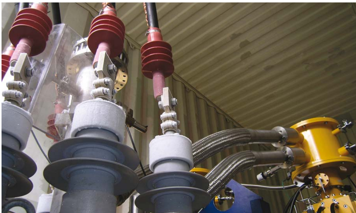
Supraleitender Strombegrenzer – effizientere Netzstrukturen ohne Abstriche bei der Sicherheit
