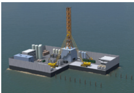
Die Probebohrungen sollen mit einer vergleichsweise kleinen Bohranlage von einer auf dem Boden verankerten Ponton-Konstruktion aus erfolgen.
