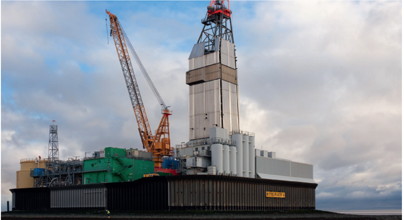
Die auf einer Sandbank stehende Wannenkonstruktion der Bohr- und Förderinsel Mittelplate mit dem verkleideten Bohrturm sowie dem umliegenden Kolkschutz
