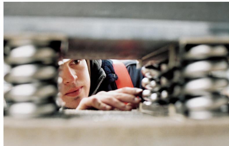
Inspektion der schwingungsgedämpften Lager eines Elektroantriebs im Kraftwerk.
