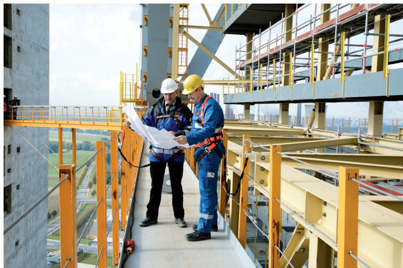
Ortstermin in 107 m Höhe: Manfred Gatz (r.) mit Baustellenleiter Manfred Hensel.
