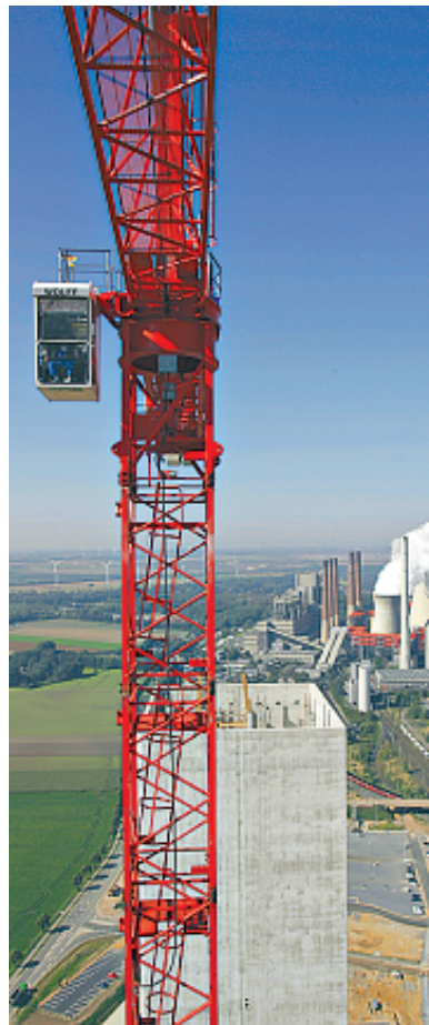
Eine der Aufgaben von Hans-Werner Leistner in diesen Wochen: Betonfertigteile in die Treppentürme heben und bis zum Einbauort ablassen.
