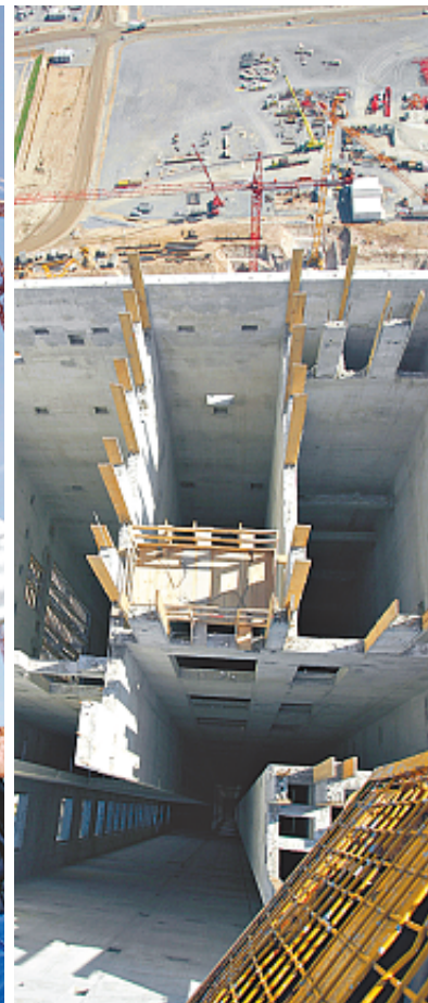
Eine der Aufgaben von Hans-Werner Leistner in diesen Wochen: Betonfertigteile in die Treppentürme heben und bis zum Einbauort ablassen.
