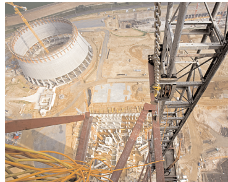
Blick aus dem Bauaufzug: Der Fahrkorb zieht sich über eine Zahnstange am Gittermast hoch – von 0 auf 173 Meter in vier Minuten. Die rustikale Optik des Aufzugs täuscht über die eingebaute Sicherheit hinweg.
