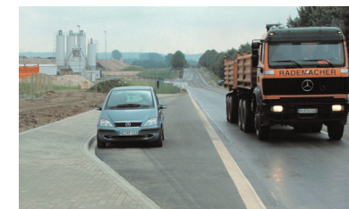
An der L 375 hat RWE Power eine Haltebucht für Autofahrer geschaffen. Sie können nun gefahrlos einen Blick auf die Baustelle werfen.
