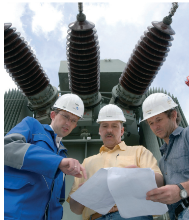
Über die Schaltpläne am Trafo informieren sich die beiden Bereichsbauleiter Steffen Teitge (l.) und Norbert Breuer (M.) sowie Fachbauleiter Carsten Pohl.
