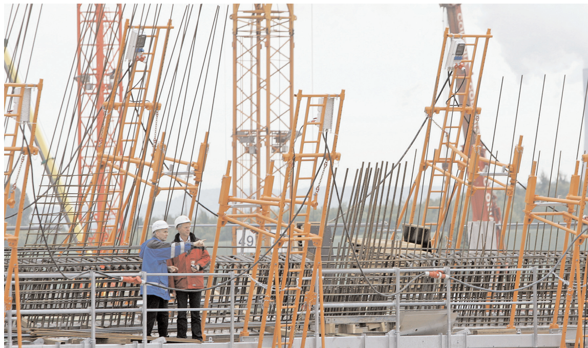
Sicherheitsingenieur Andreas Kablau (l.) organisiert zurzeit den Einsatz der Kräne beim Bau der Kühltürme. Hier erläutert er dem Vertreter des beauftragten Kühltumbauers Wiemer & Trachte, Roland Albert, wie die Kräne arbeiten sollen.
