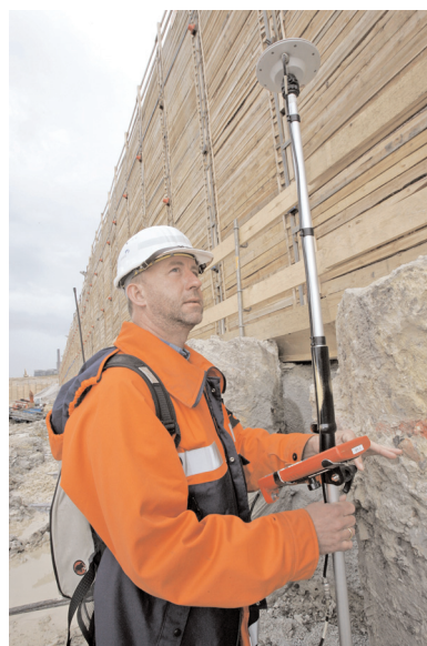
Dieter Wilms vermisst das komplette Gelände der BoA-Baustelle.
