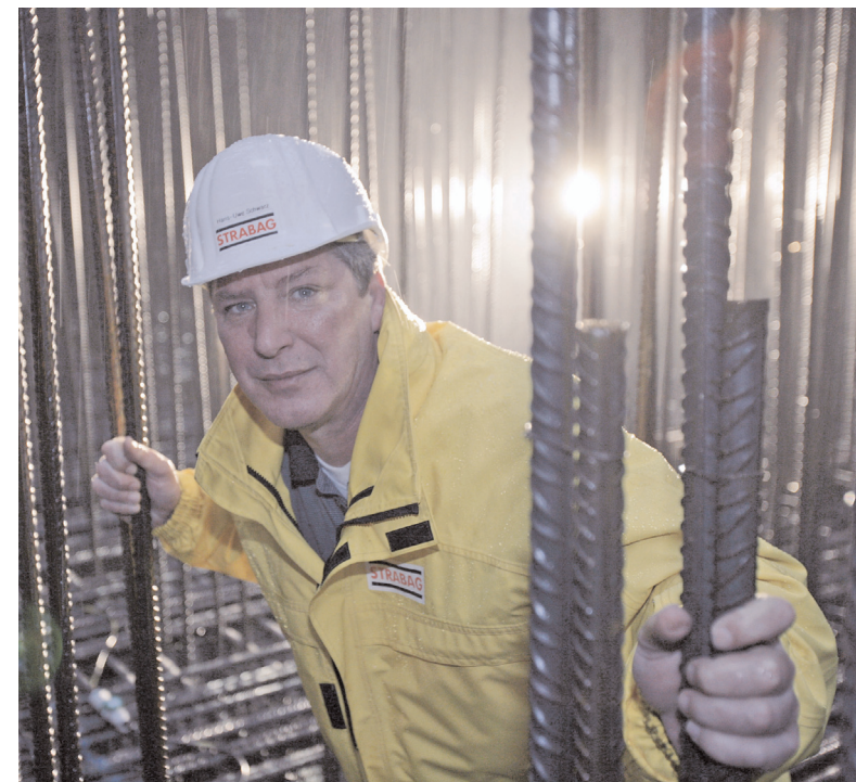
Hans-Uwe Schwarz im Geflecht des Bewehrungsstahls, der vollständig im Beton untergeht.
