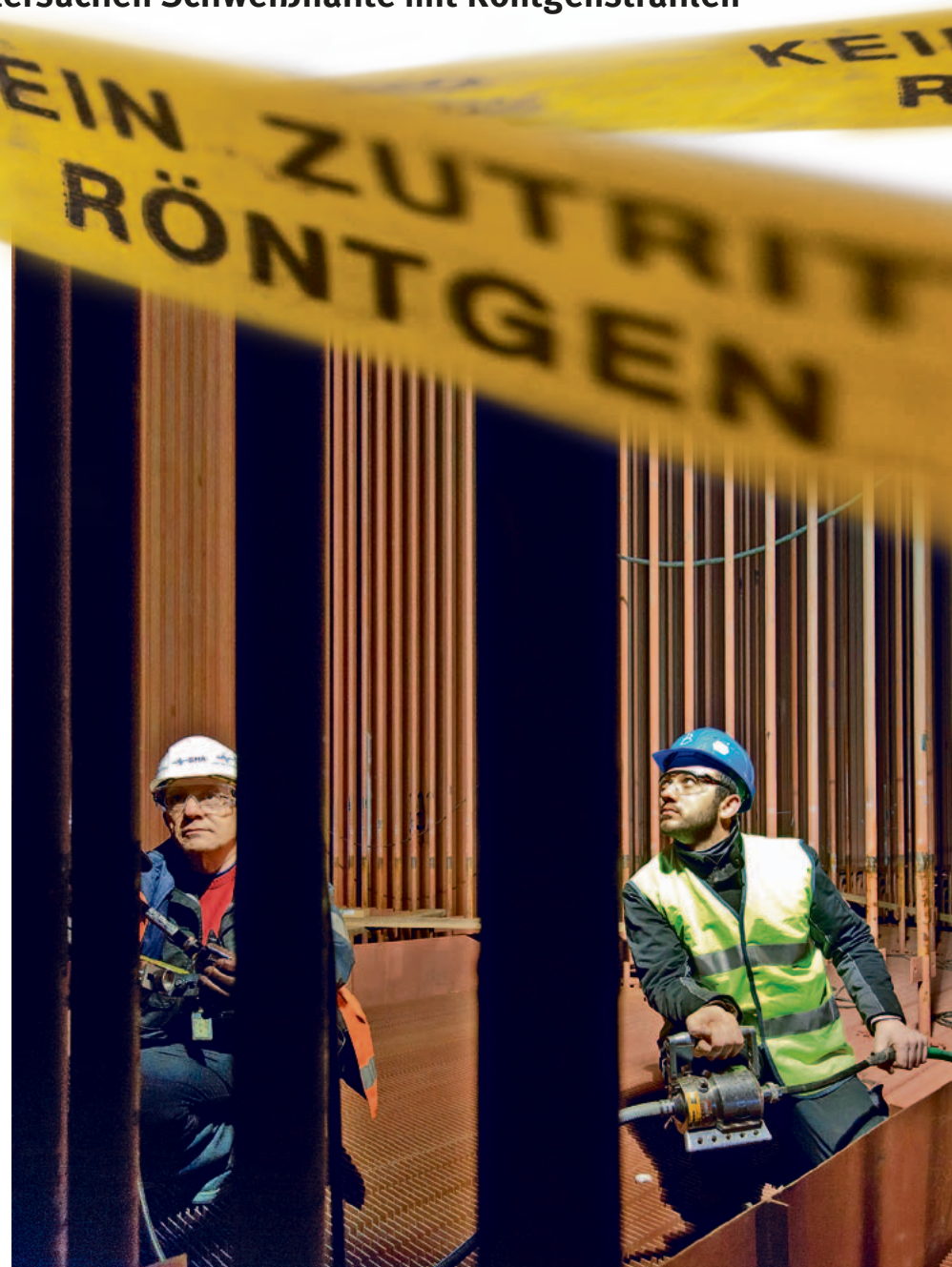
Die Nähte der Rohre im Dampferzeuger werden mit Röntgenstrahlen kontrolliert
