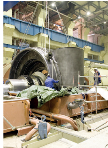
Draußen Frost, drinnen Frust? Monteure wie Material brauchen Plusgrade
