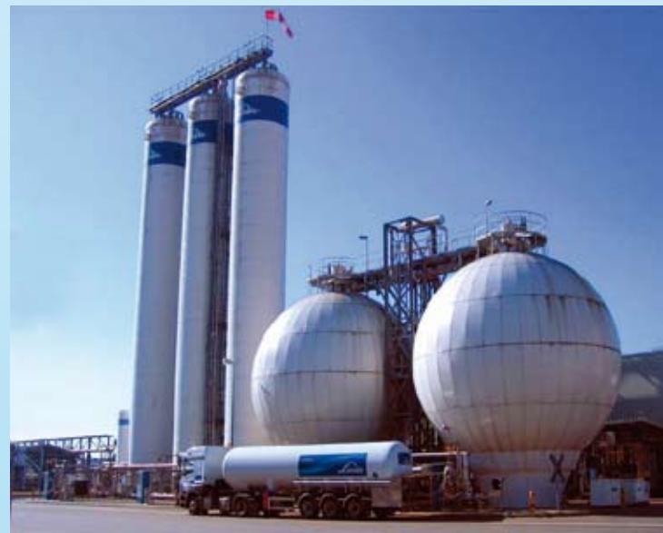
CO 2 -Anlage der Linde Group
