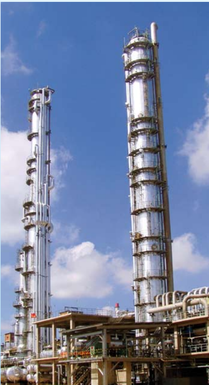
Anlage für eine chemische Wäsche
