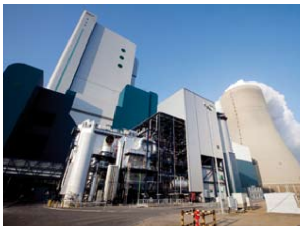
Kraftwerk Niederaußem mit BoA-Block und WTA im Vordergrund.
