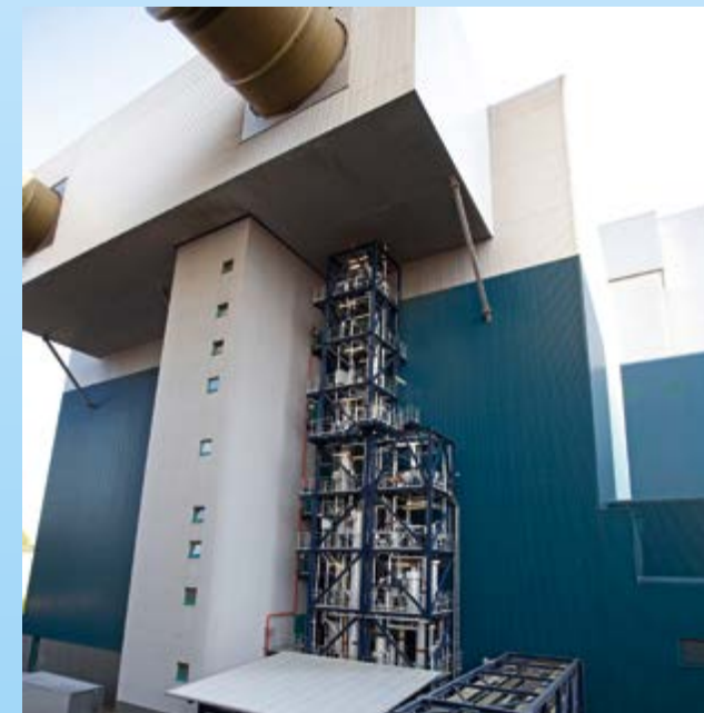
Die CO 2 -Wäsche entfernt Kohlendioxid aus dem Rauchgas.
