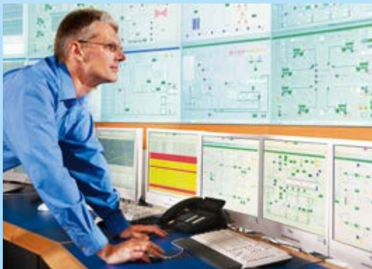
Der Leitstandfahrer beobachtet und bedient einen kompletten Kraftwerksblock.
