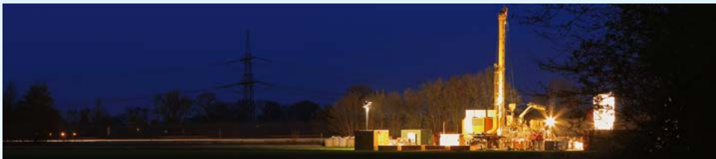
Nachtschicht: Brunnenbohrung bei Kerpen-Manheim.
