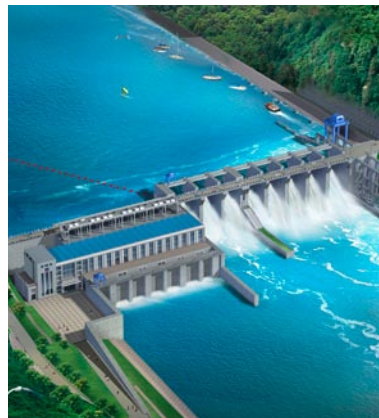
Wasserkraftwerk in Xiaoxi, China
