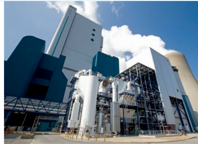
WTA-Prototypanlage für die Trockenbraunkohlentechnologie in Niederaußem
