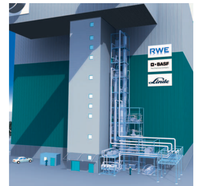
Pilotanlage für die CO 2 -Rauchgasreinigung am BoA-Block in Niederaußem
