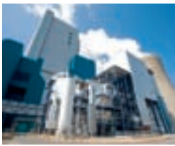
WTA-Anlage; Versuchsbetrieb ab 2009 – CO 2 -Minderung
