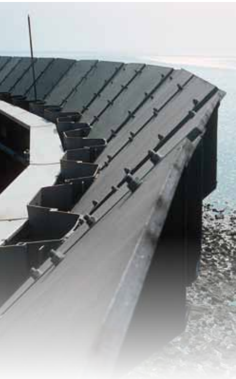
Oben: Spundwand mit Wellenabweiser. Zum offenen Meer hin beträgt die Höhe 11 Meter. Von außen kann nichts eindringen, abgesehen von Regen und Spritzwasser. Von innen kann nichts nach außen gelangen, auch kein Regenwasser.
