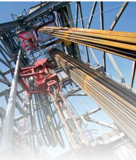
Oben: Erfahrene Bohrarbeiter gewährleisten einen sicheren Bohrbetrieb.
