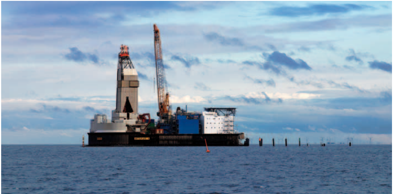
Höchste Sicherheitsstandards auf der Bohr- und Förderinsel Mittelplate
