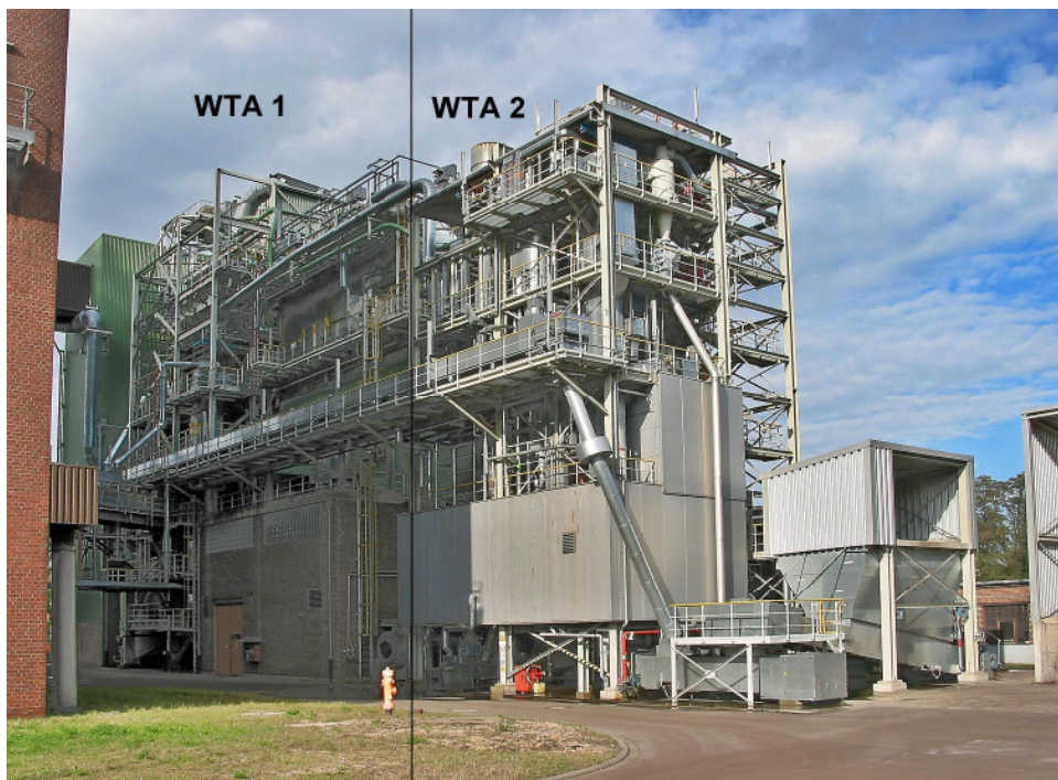
Abb. 9: Foto der WTA 1 Anlage (linker Teil) und WTA 2 Anlage (rechter Teil) Frechen
