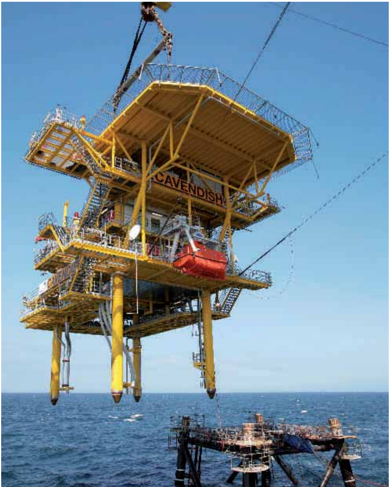
Der fast 600 Tonnen schwere Aufbau der Erdgas-Förderplattform Cavendish wird mit einem Schwimmkran auf dem Unterbau (Jacket) abgesetzt.
