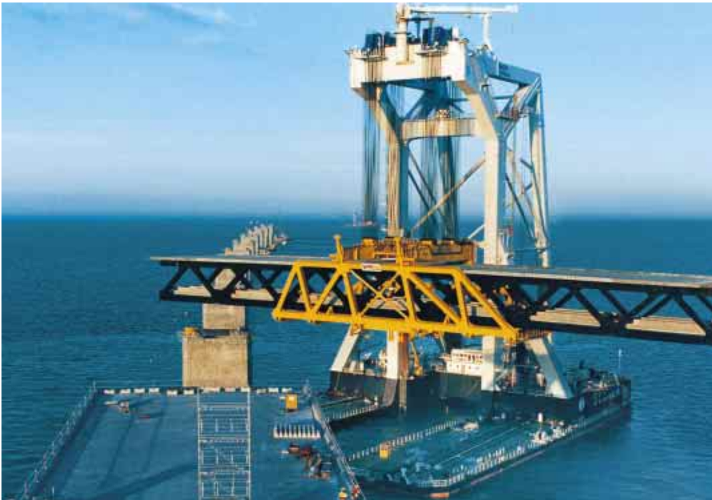
Der größte Schwimmkran der Welt beim Bau der Öresund-Brücke zwischen Dänemark und Schweden.
