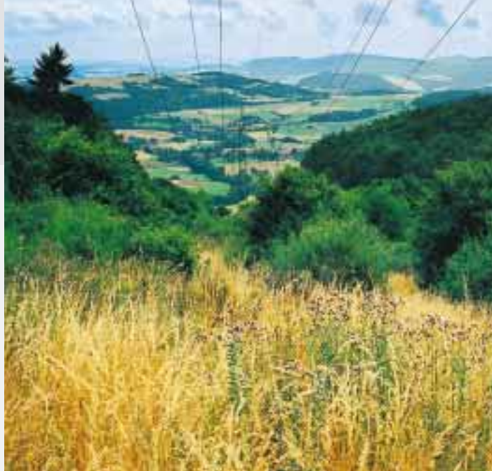
Biotopmanagement in Freileitungstrassen – 110-kV-Leitung der RWE Energie.
