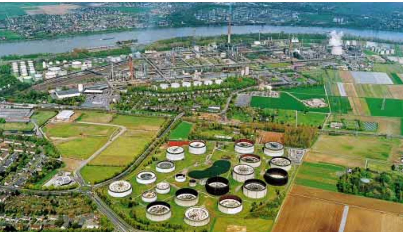
Die DEA Raffinerie Wesseling verarbeitet Rohöl zu Mineralölprodukten und petrochemischen Grundstoffen.
