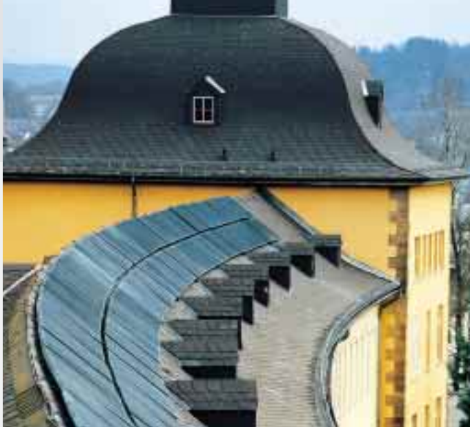
Aus Fördermitteln des Umwelttarifs finanzierte Solaranlage auf dem Dach des Emmy-Noether-Campus der Universität GHS Siegen.
