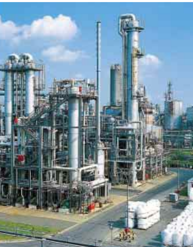
Anlage zur Produktion von nativen Fettalkoholen im CONDEA Werk Brunsbüttel.
