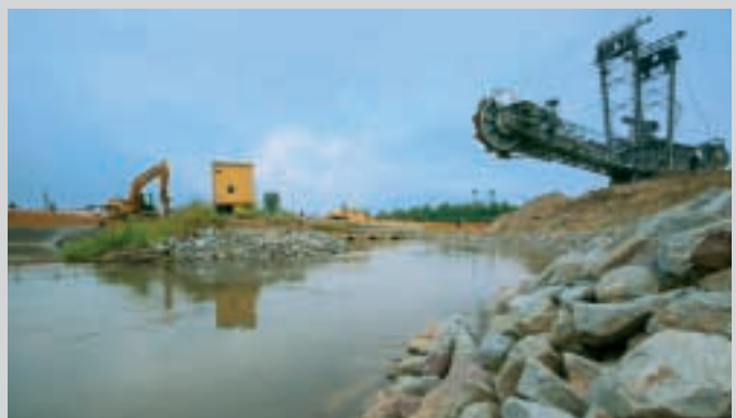
Überquerung der Erft: Aus Kies und Natursteinen wird der Übergang geschaffen.
