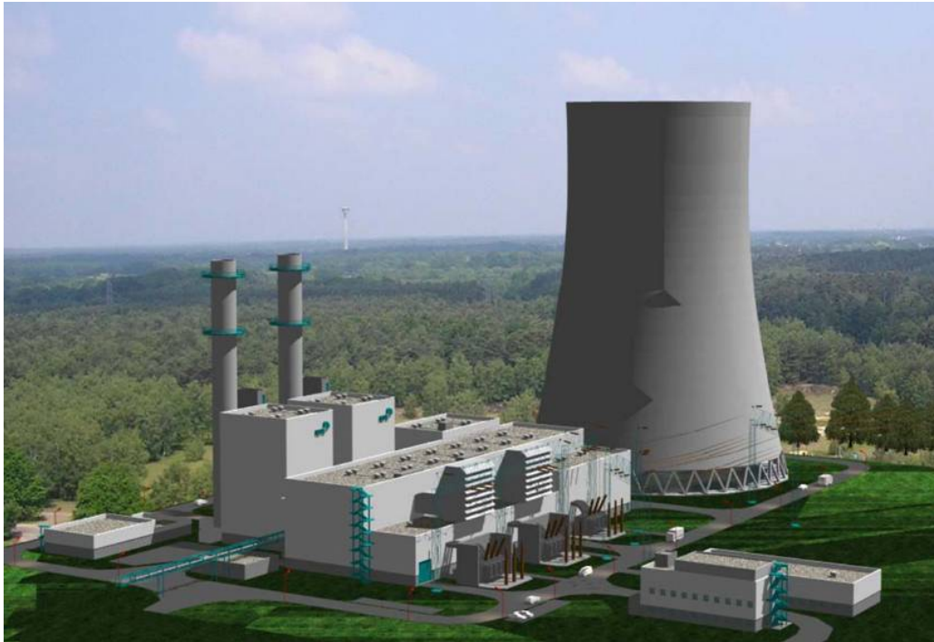
Lingen 875-MW CCGT
