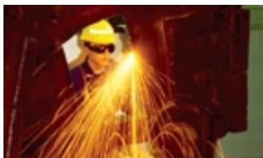
Сварочные ремонтные работы
