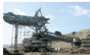
Восстановление многоковшового роторного экскаватора, Косово
