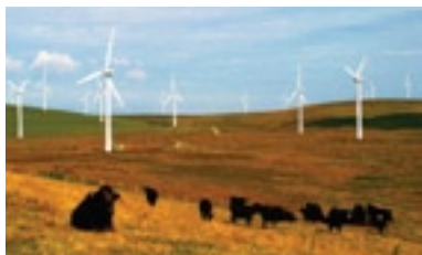
Наземная ветряная электростанция Bryn Titli
