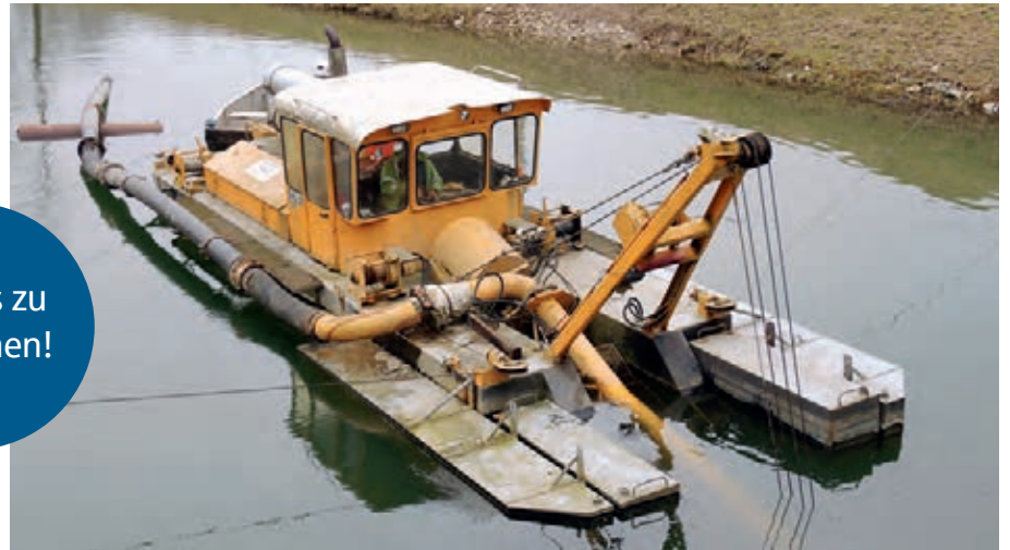
↑ FREIER ZUFLUSS: Der Schwimmbagger geht der Sedimentablagerung auf den Grund.
