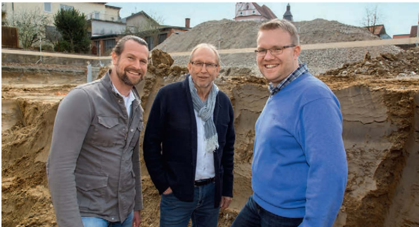
↑ ERDBEWEGUNG: Stefan Baisch, Erster Vorsitzender des Historischen Vereins Günzburg (re.), und die beiden Geschäftsführer der Günzburger Wohnungsbaugesellschaft Arcasa, Joachim Heinisch (li.) und Wolfgang Scholz, achten beim Bau auf wertvolle Fundstücke.
