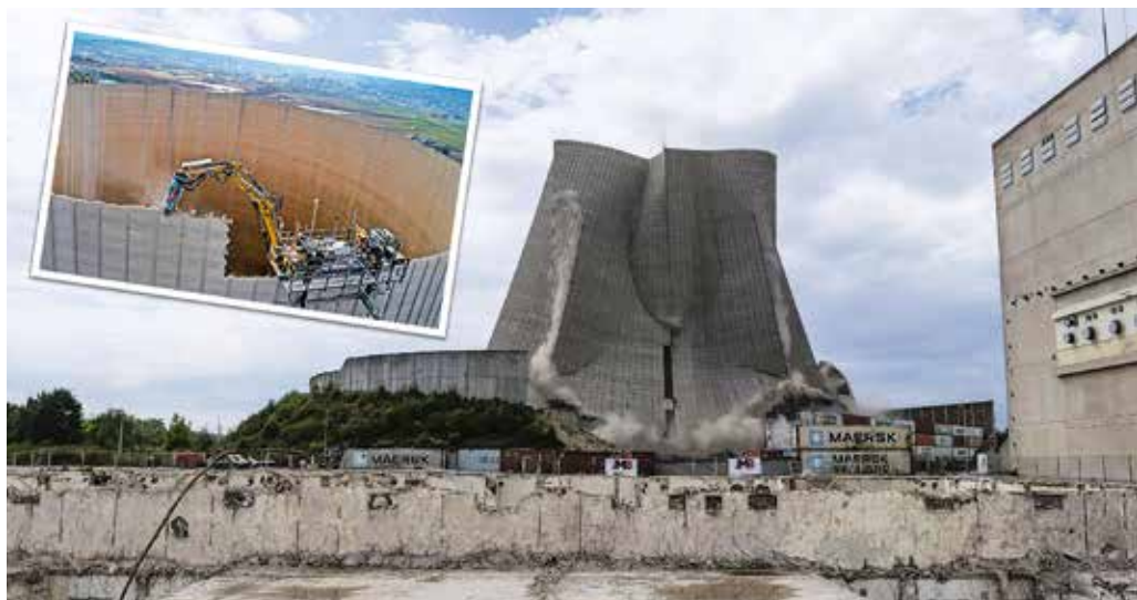
Beim Rückbau des ehemaligen Kernkraftwerks Mülheim-Kärlich kam ein Abbruchroboter zum Einsatz.
