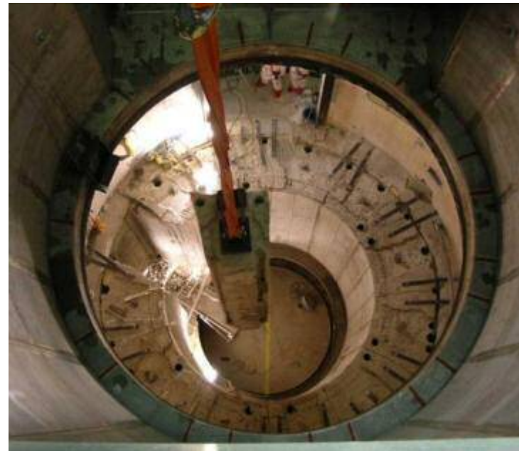
Beispiel biologischer Schild während des Abbaus (Gundremmingen Block A)
