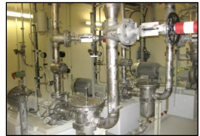
Beckenkühlsysteme im Ringraum angeordnet
