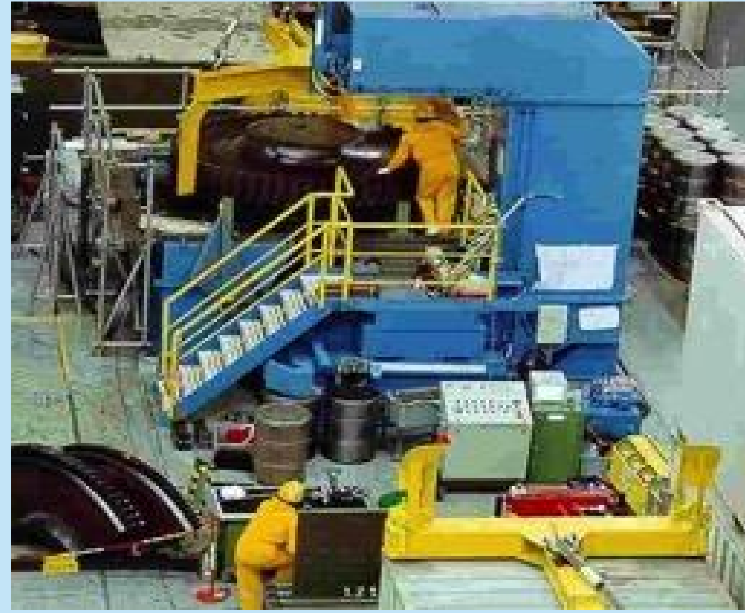
Ausbau und Nachzerlegung am Standort
