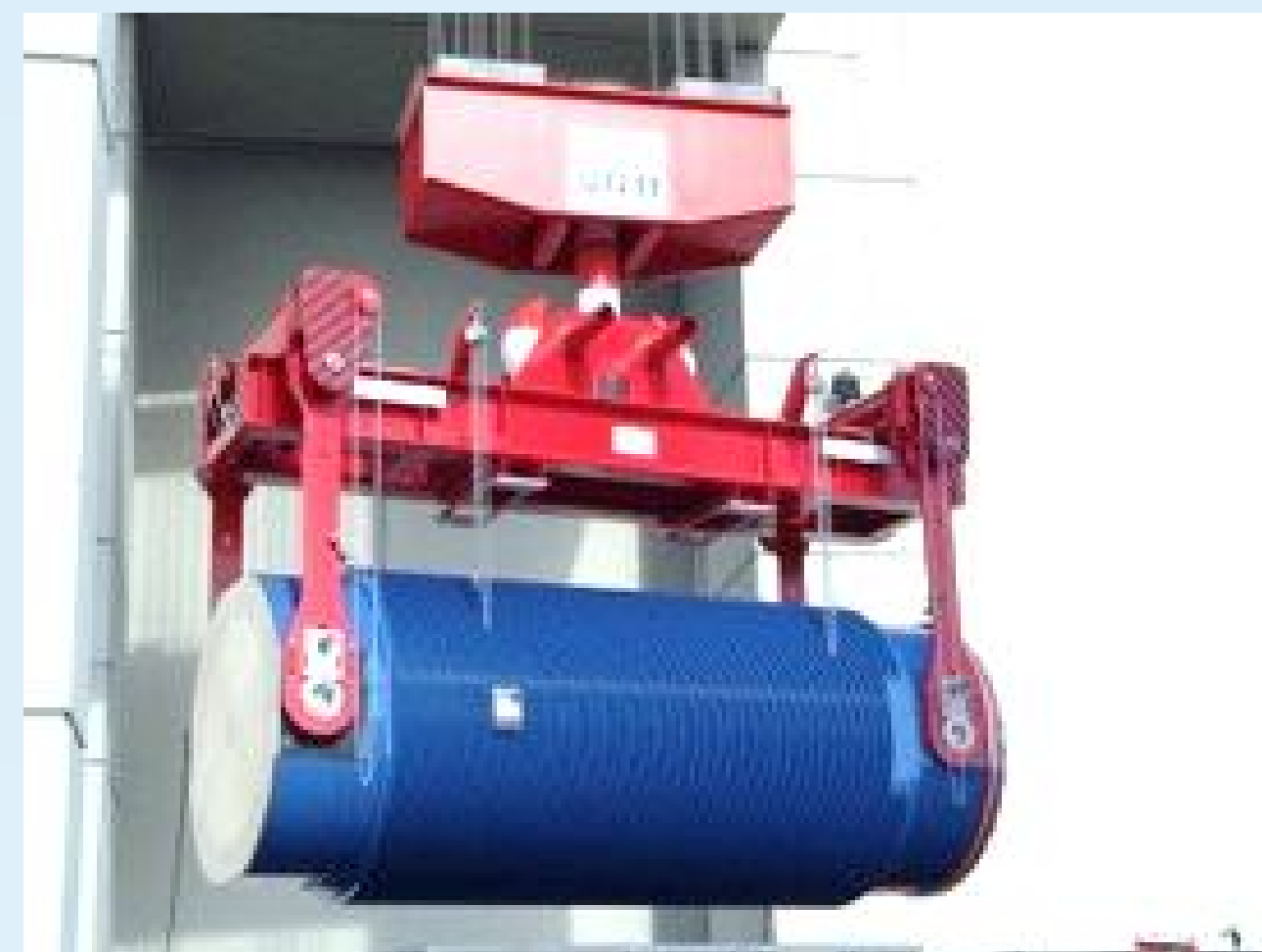
Einschleusen in das Reaktorgebäude
