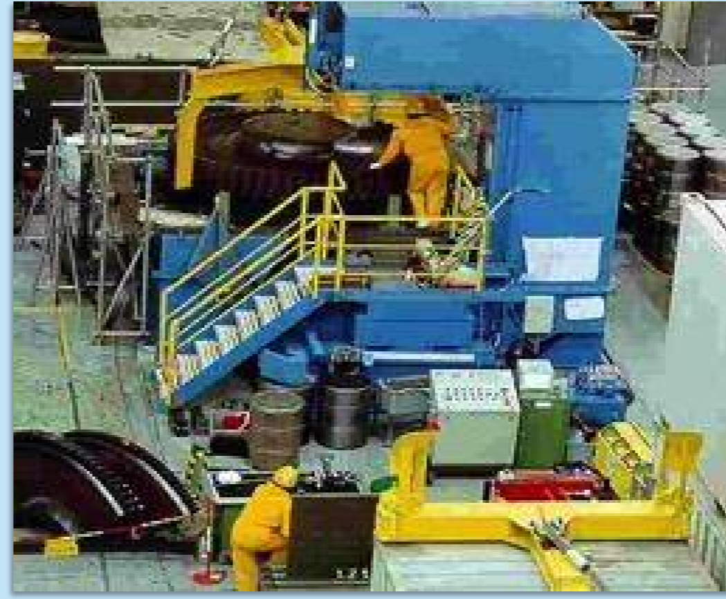
Ausbau und Nachzerlegung am Standort
