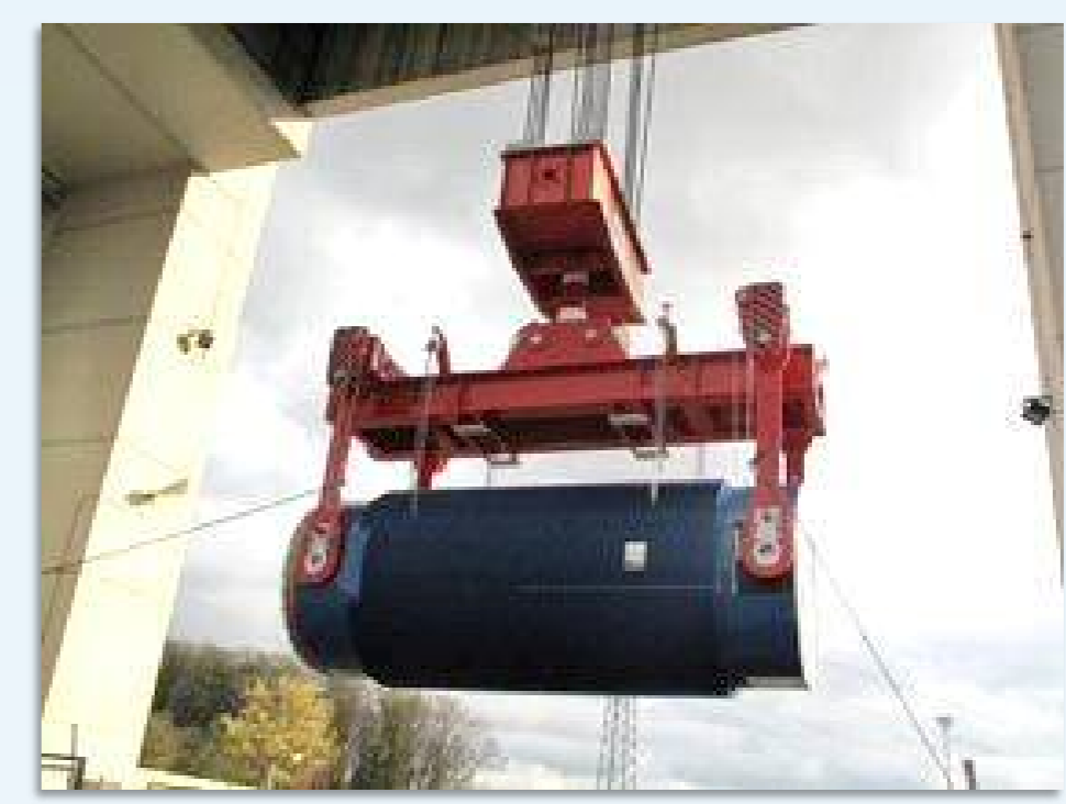
Ausschleusen aus dem Reaktorgebäude
