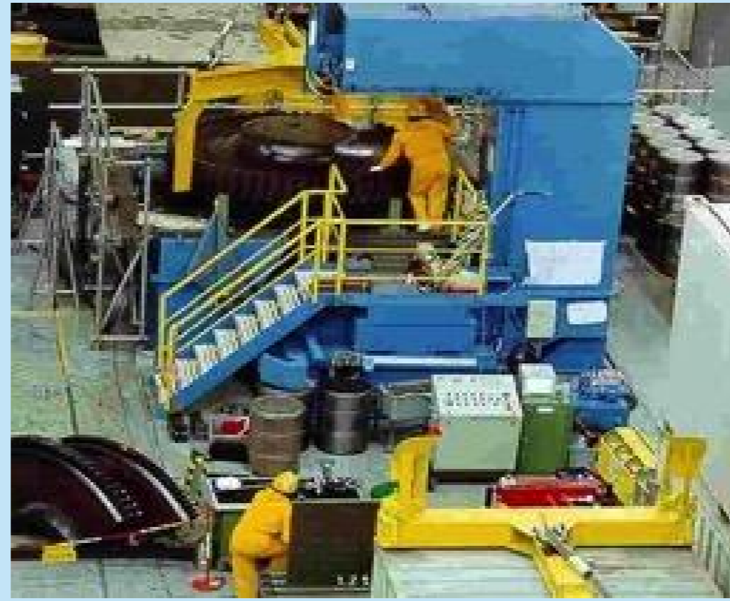
Ausbau und Nachzerlegung am Standort
