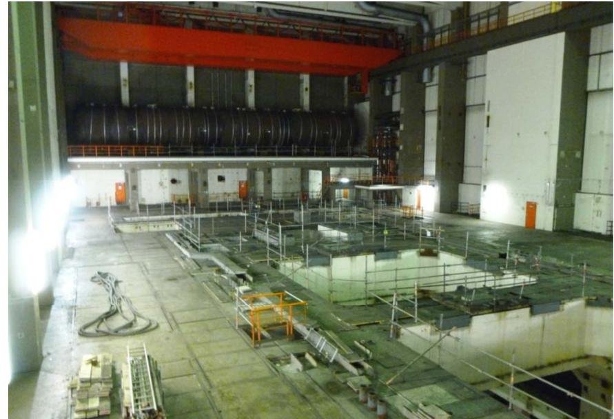
Im Maschinenhaus wurden bis April 2012 ca. 10.000 t abgebaut. Große Einzelteile, allen voran die Dampfturbine und der Generator, wurden verkauft.
