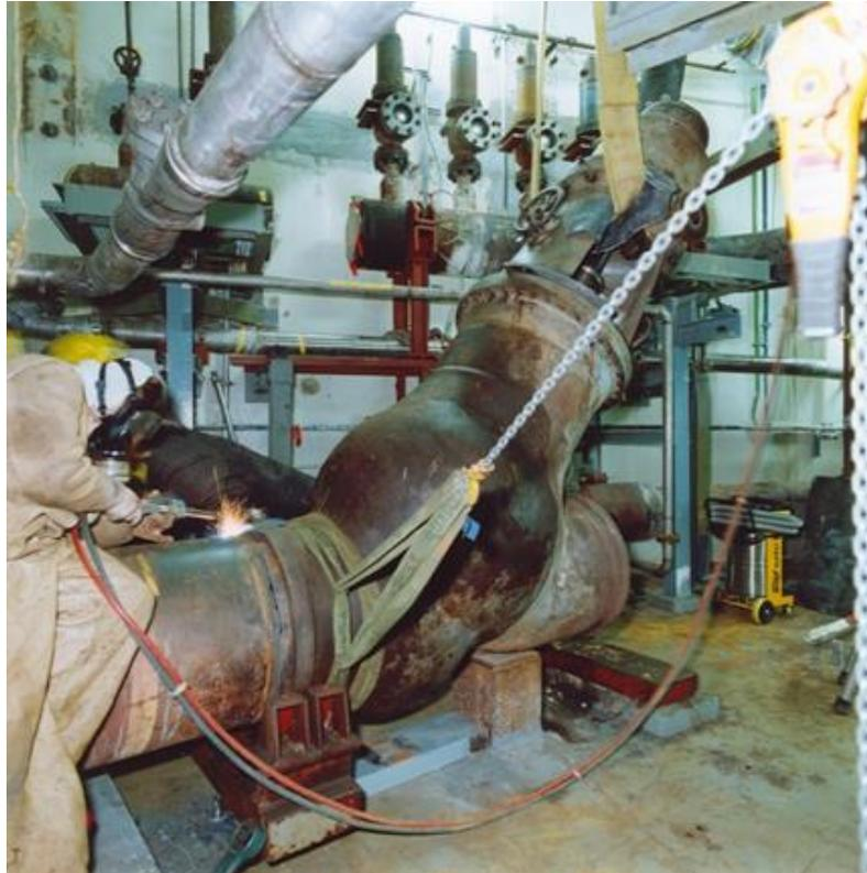
Abbildung 20: Autogenes Brennschneiden einer Absperrarmatur
