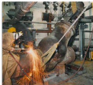
Brennschneiden - Ausbau
