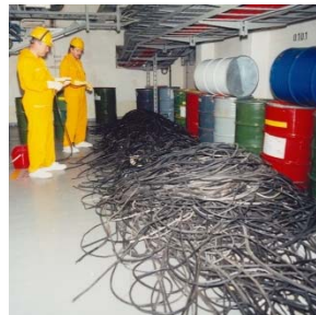
Dekontamination von Elektrokabeln durch Trennung von Kupfer und Isolierung
