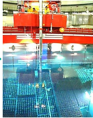
Brennelemente im Lagerbecken
