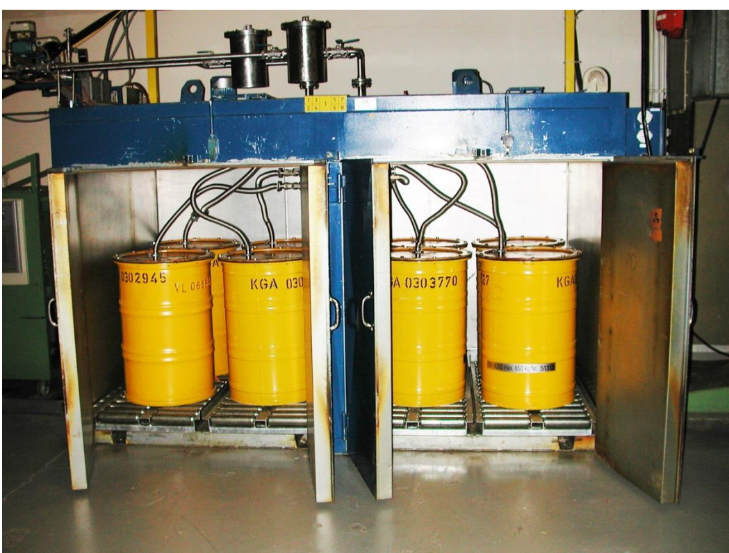
Anlage zur Trocknung von radioaktiven Abfällen
