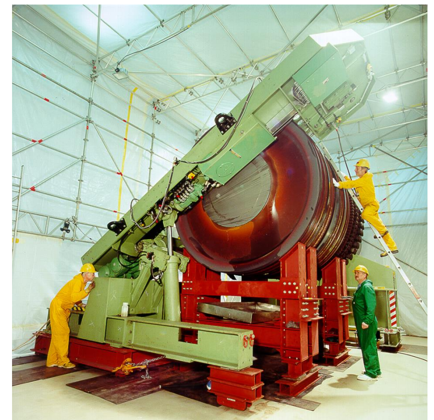
Zerlegung mit Bandsäge
