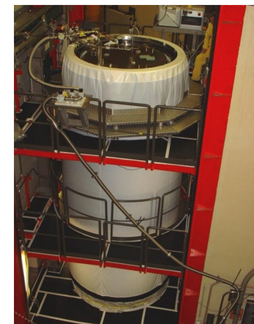
Abfertigung des CASTOR-Behälters in der Anlage
