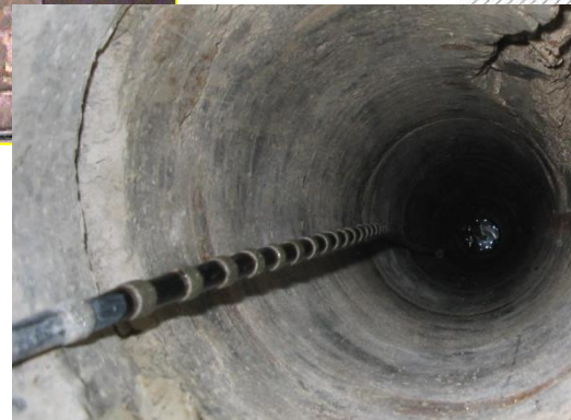
Zerlegung mit „Seilsäge“
