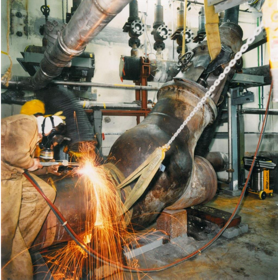
Autogenes Brennschneiden - Primärabsperrarmatur
